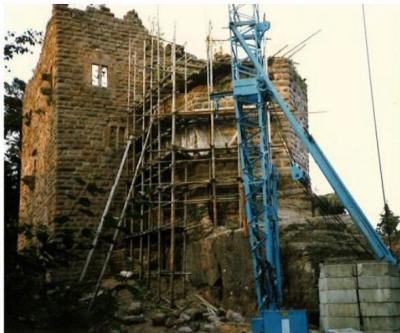
Après les travaux de débroussaillage, le château révélait quelques sérieux dangers d'éboulement, qui ont nécessité de gros travaux de réhabilitation. La pose d'un échafaudage en bois a permis aussi de rétablir les sommets des murs. Photo DR
