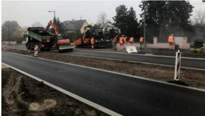
La pose de l'enrobé, en cours, devrait permettre l'ouverture du deuxième tronçon à la circulation dès ce week-end. Photo Jean Haefele
